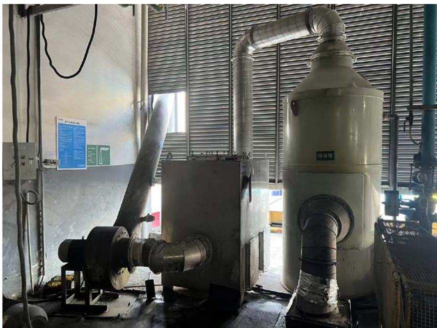
图 4-4 项目有机废气处理装置
