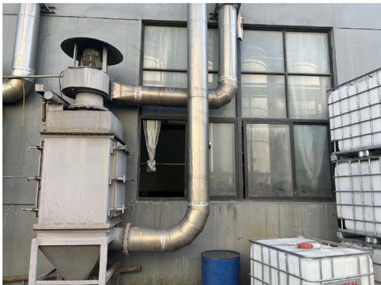
图 4-3 项目除尘装置（上下分别为 2#、6#除尘装置）
